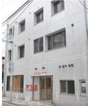
te to te～つなぐん家～が入るビル
