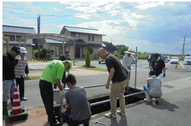
～有志で行った安全対策作業の様子～
