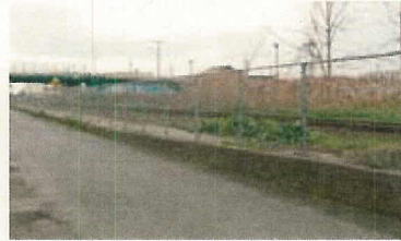
行政への働きかけでフェンスが設置されました
