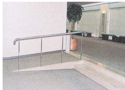
階段の部分に、車いすでも通れるようにスロープがつけられています。
